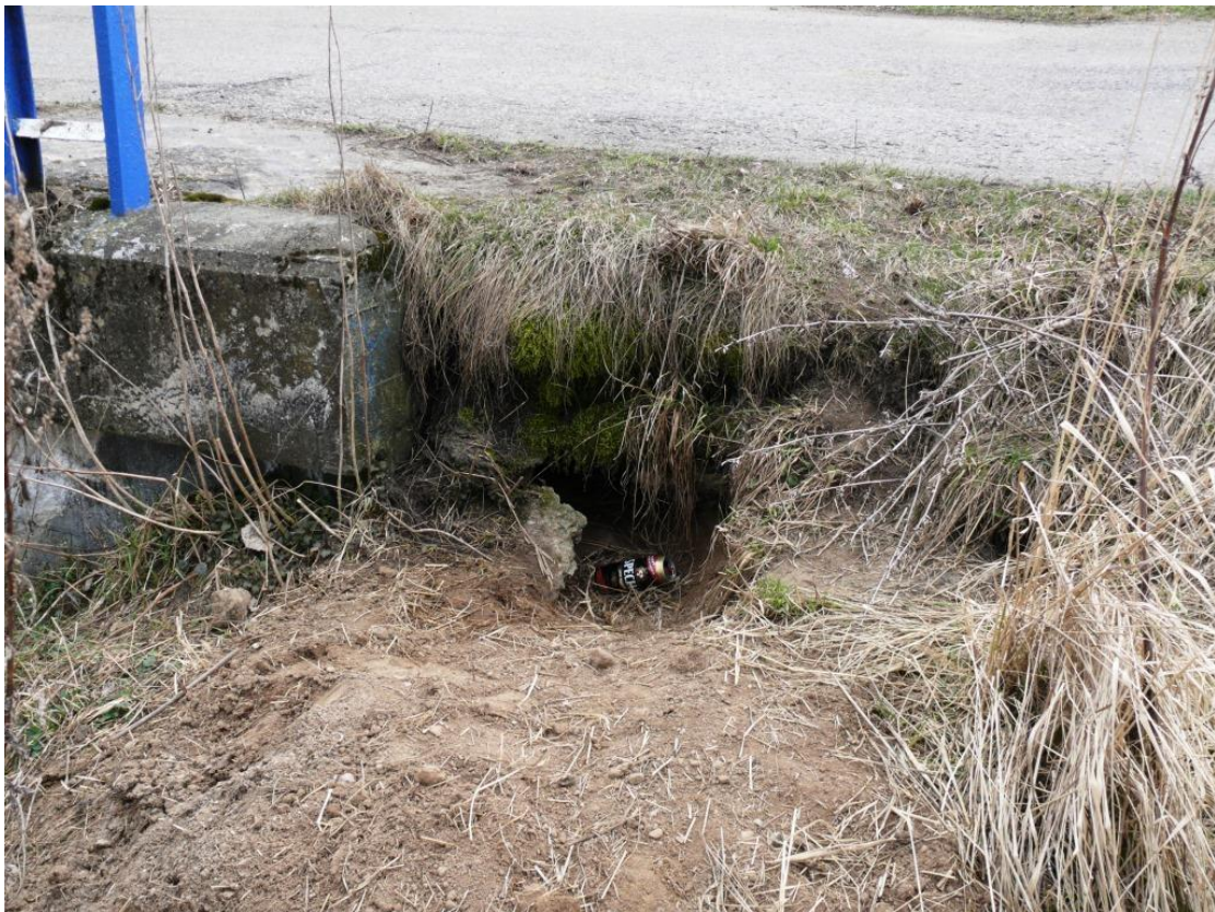
Fot.Nr.4. Ubytki gruntu w skarpie za skrzydełkiem prawobrzeżnym od strony WG z kierunku Lwowca.
