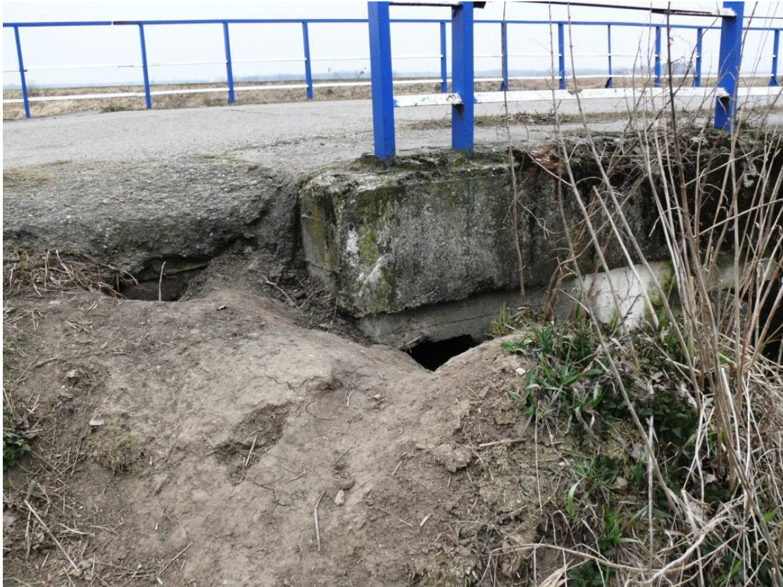
Fot.Nr.5. Ubytki gruntu w skarpie za skrzydełkiem prawobrzeżnym od strony WD z kierunku Lwowca.
